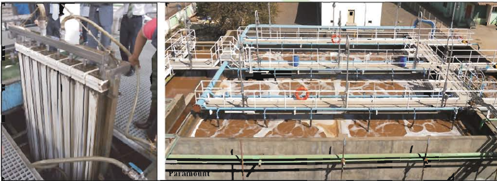
Hollow Fibre Membrane Sanofi Aventis, Gujarat
